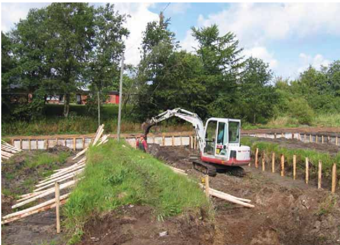
I projektet har de deltagende dambrug i forskellig grad ændret på dambrugsindretningen. På billedet ovenfor ses anlægsarbejde forud for etablering af dam med intern recirkulering.
