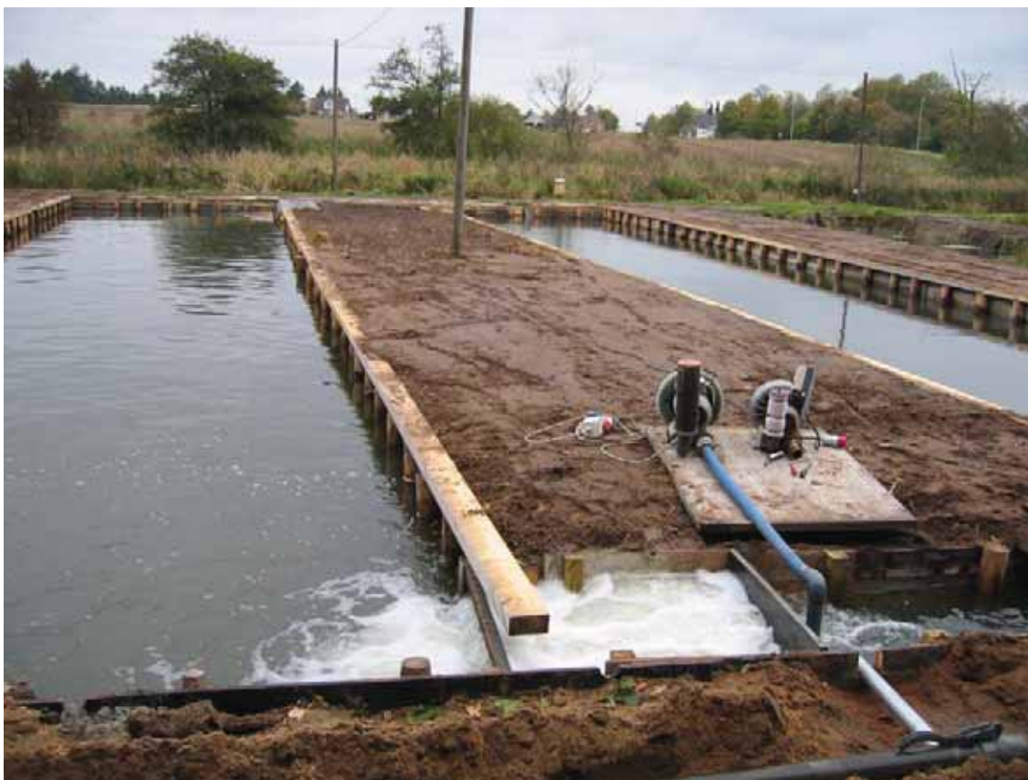
Dam med intern recirkulering fra et af de fire deltagende dambrug. Beluftningen sikrer stabilt iltindhold og skaber en vandstrøm rundt i dammen.
