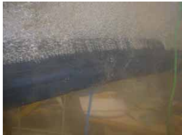
Figur 45 Rør med perforeret gummistrømpe under forsøg
