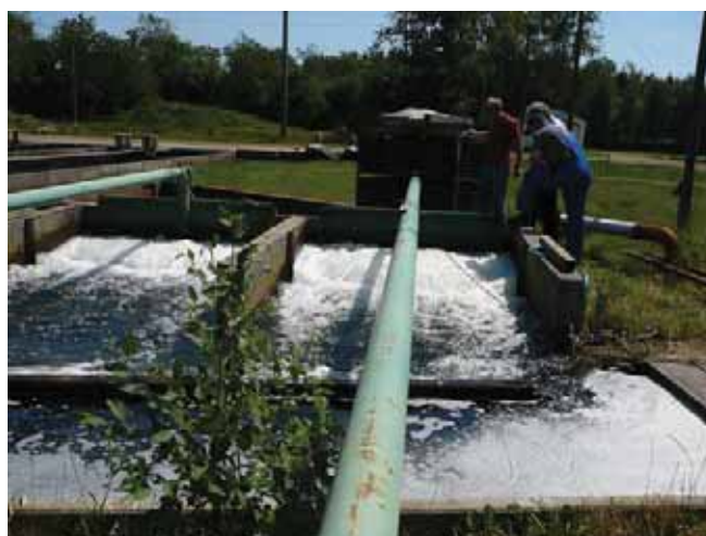
Figur 36 Mammutpumper / airlifts på Kølkær Dambrug mammutpumpen der laves målinger ved.
