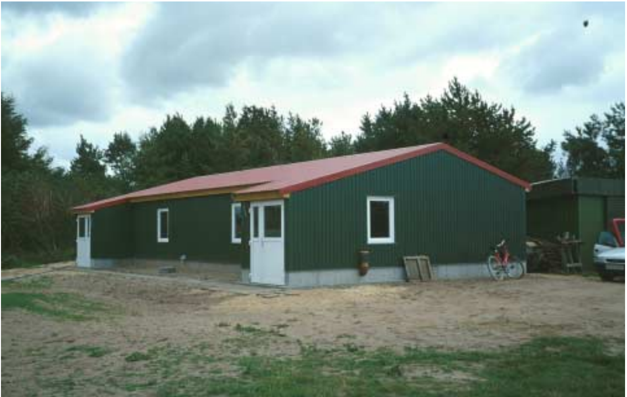
Figur 2 : Det nyetablerede forsøgsanlæg til YDS-projektet, fase II. (Fig. 2+3, Foto: Lone Madsen).
