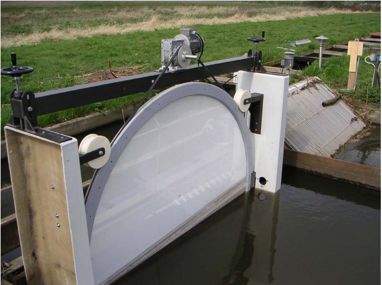
Billede 3. Billede af faunasigten efter i sætning. Ved siden af ses den traditionelle 10 mm afgitring.
