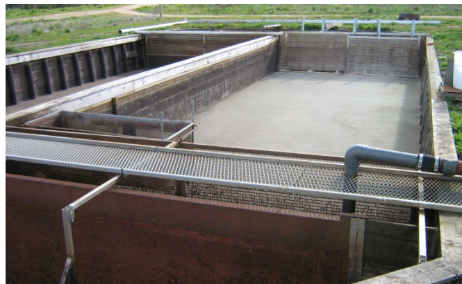
Dambrugets leveringsdam fotograferet tom og rengjort (mikrosigte isat efterfølgende)
